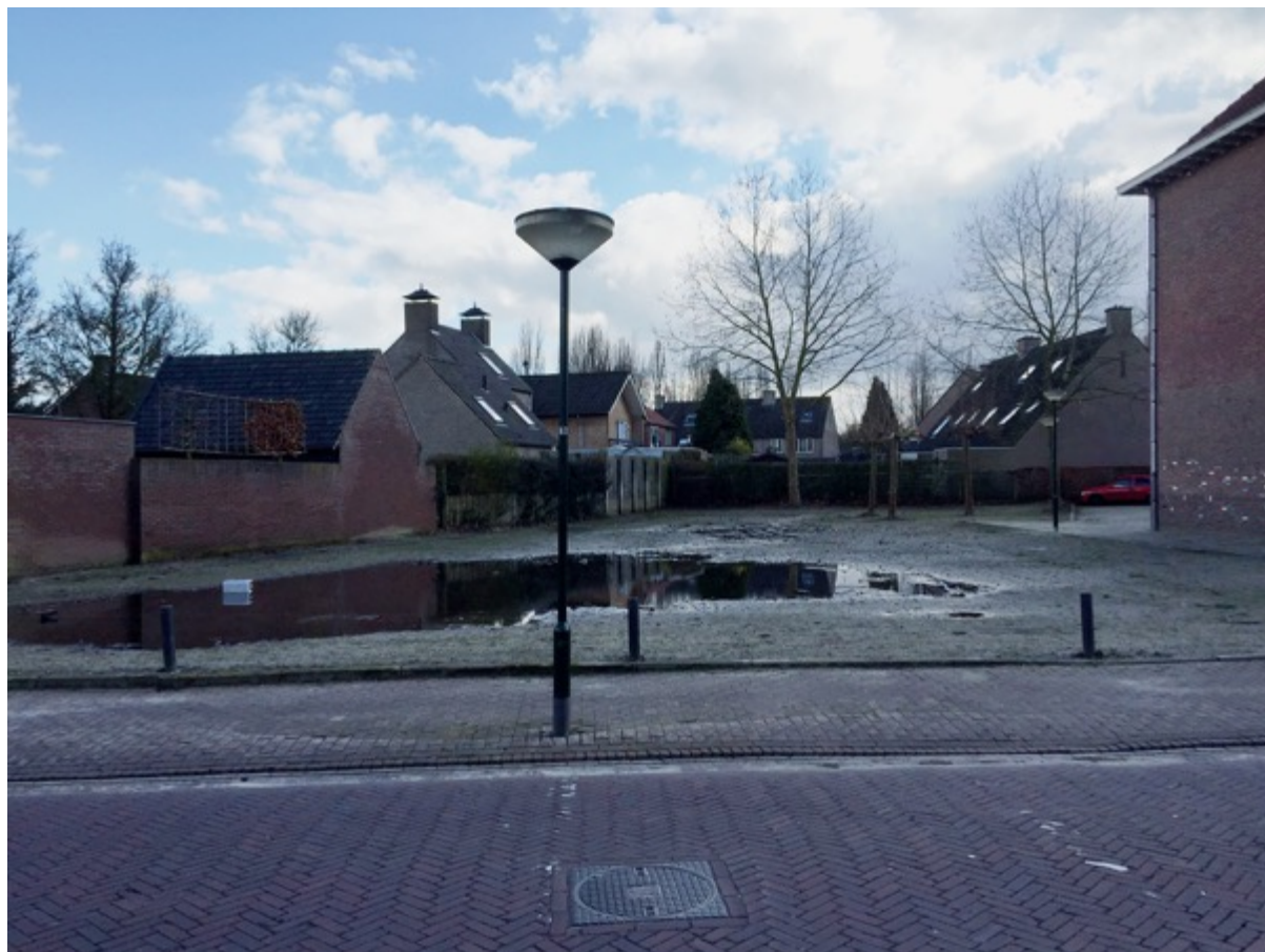
Figuur 5: Foto huidige toestand perceel aan de Varkensmarkt.
