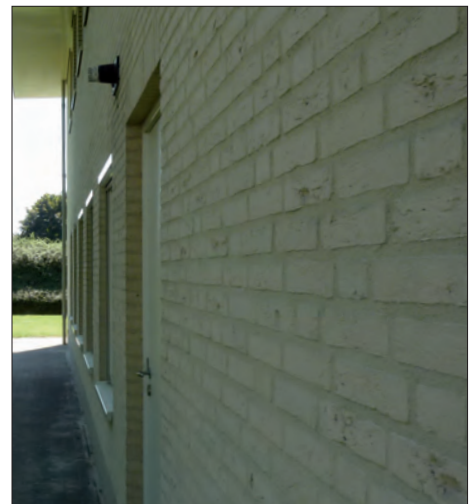
Metselwerk van baksteen
