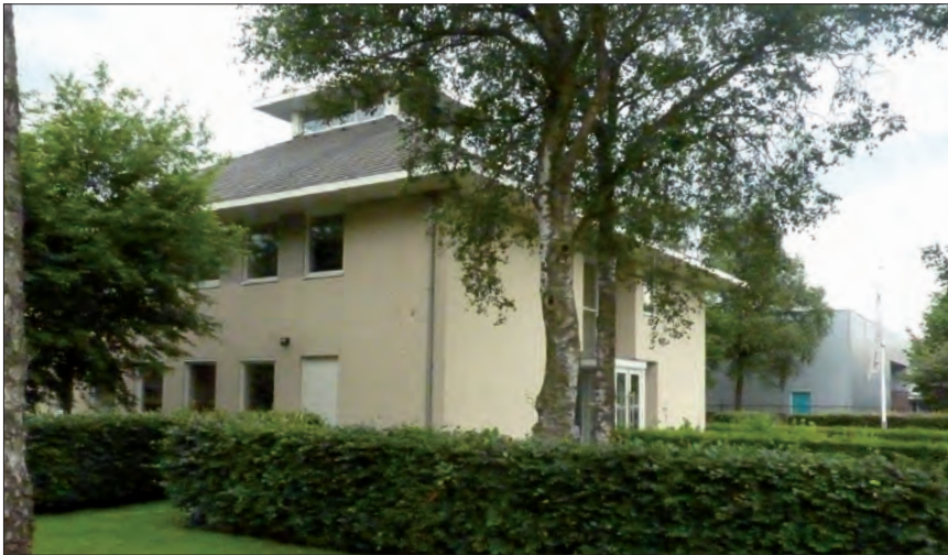
Dakranden en kozijnen in de kleur wit
