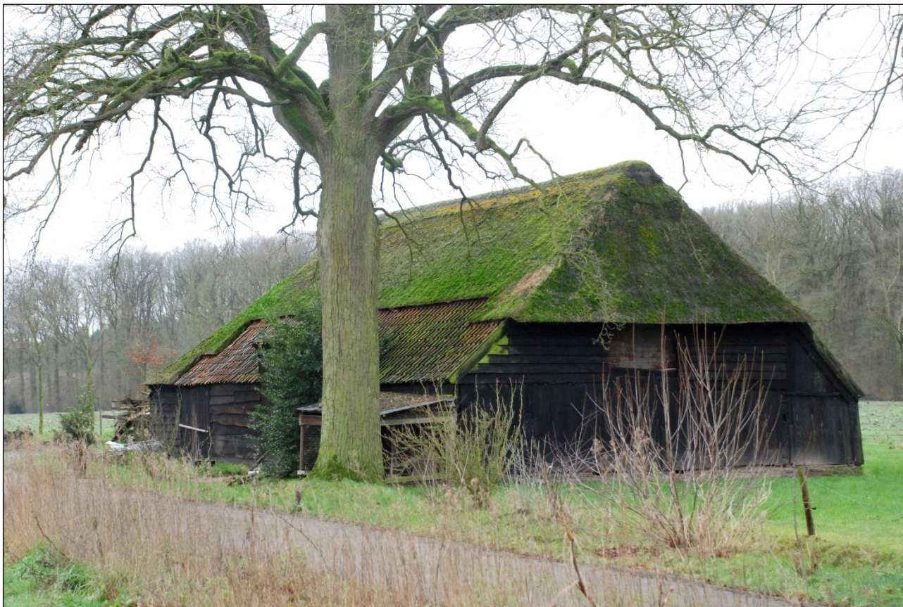
Figuur 10: Huidige staat schuur.
