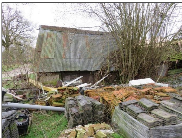
Foto 7: te slopen schuur en materiaalopslag
