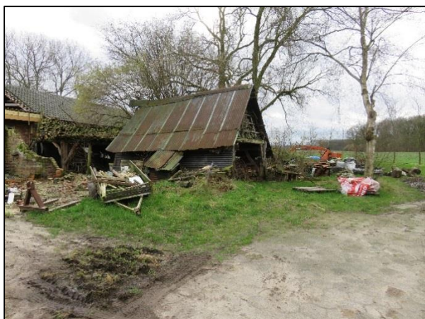
Foto 1: te slopen schuur
