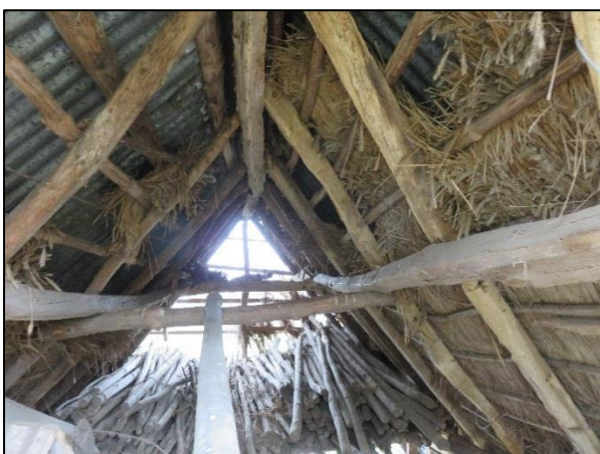
Foto 9: dak te slopen schuur
