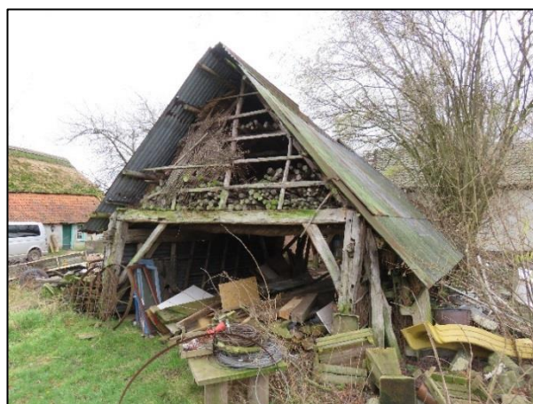
Foto 5: te slopen schuur
