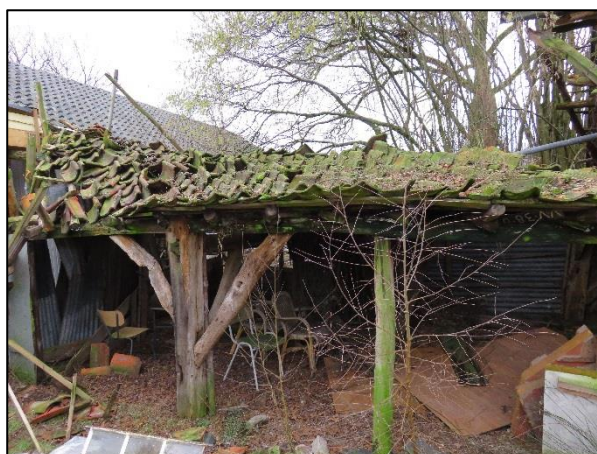
Foto 10: onderdeel te slopen schuur
