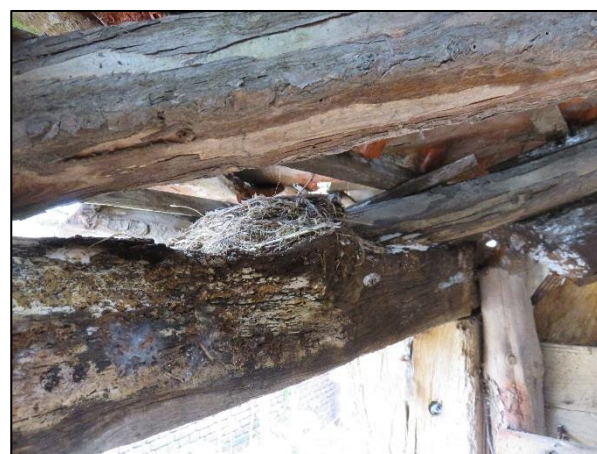
Foto 4: nest in te slopen schuur
