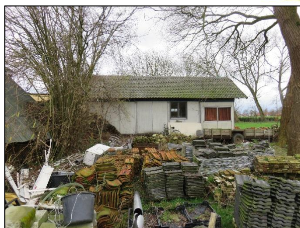
Foto 8: nieuw gebouw op locatie al gesloopte schuur
