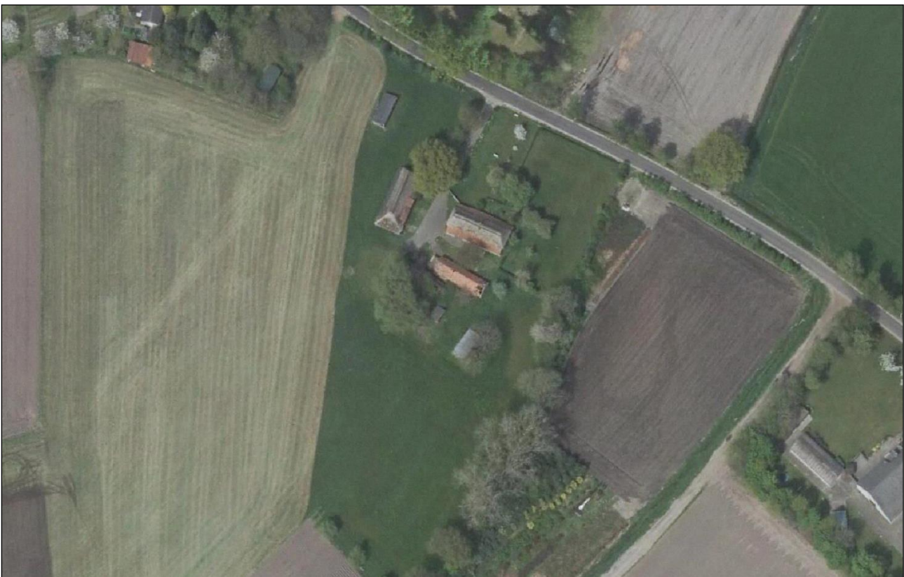
Figuur 2: Luchtfoto met daarop de huidige situatie
