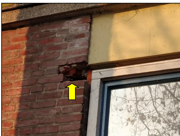
Figuur 12. Stootgaten bieden toegangsmogelijkheden tot de spouwmuur.
