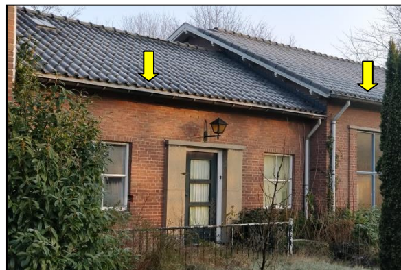
Figuur 10. Ruimtes tussen het dak en de dakgoot bieden potentieel geschikte ruimtes voor de huismus.
