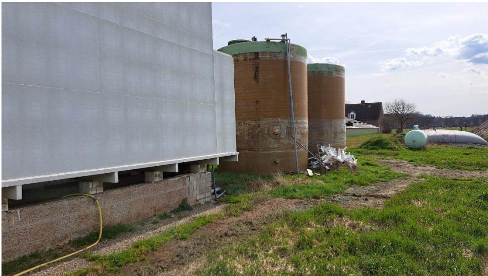
Spuiwateropslag van de chemische luchtwater in polyester silo's
