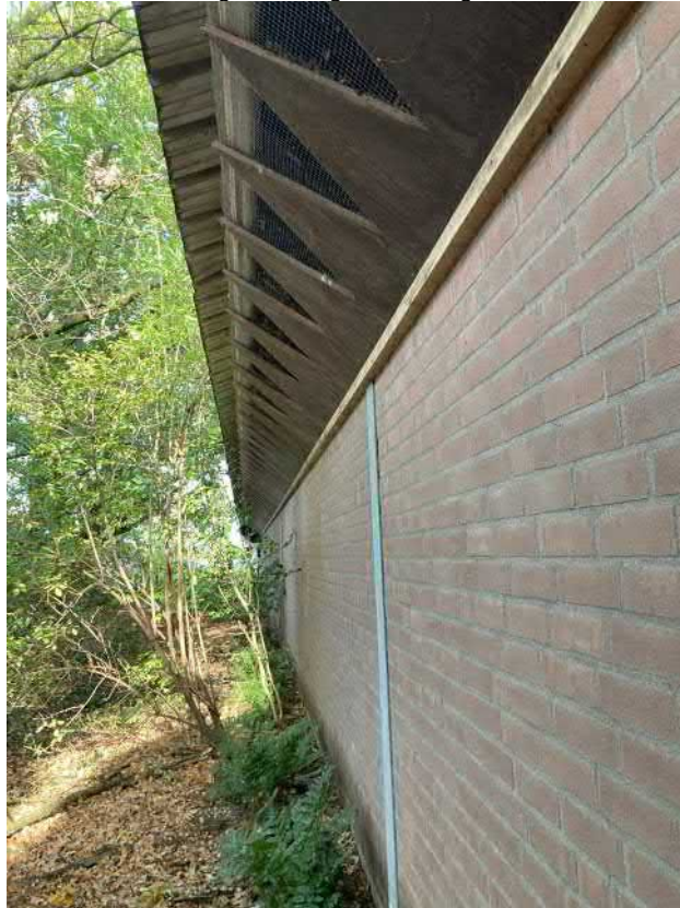
• Afbeelding 20: inlaat gesloten met gaas
