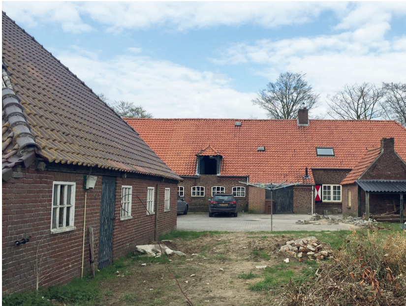
bebouwingsensemble: boerderij, schuur en 'bakhuisje'
