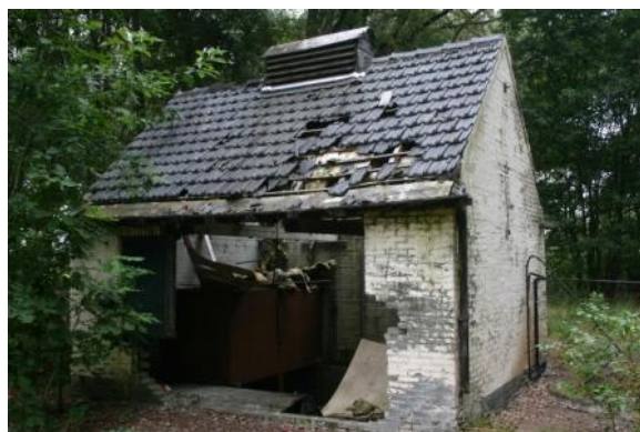
Figuur 2. Het voormalige pompgebouw
