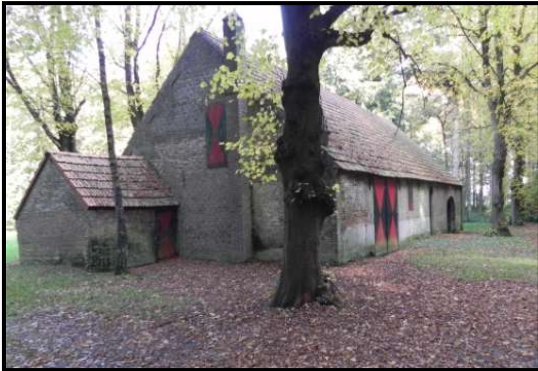
Foto: huidige situatie Roover'sche schuur
