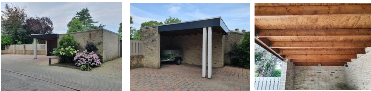
Zicht op te slopen schuurtje en carport vanuit de Bolakker en een indruk van de carport.
