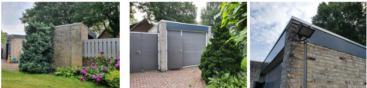
Te slopen schuurtje en carport aan de voorzijde en detail van het dak en dakrand van het schuurtje.
