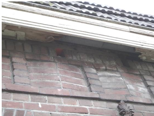
Gaten muur en dakrand woonhuis.
