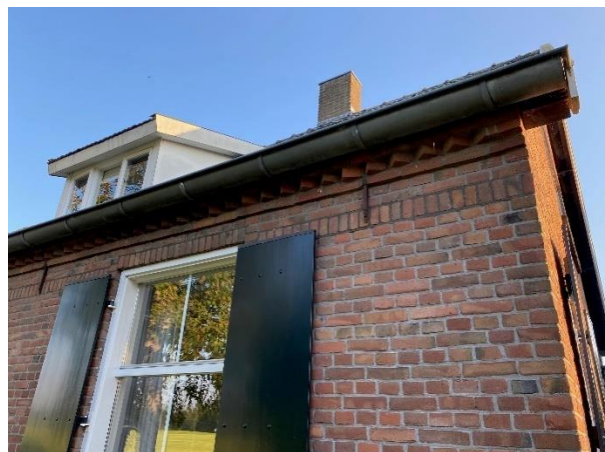
kruisverband metselwerk, muurankers en muizentand onder zinken dakgoot
