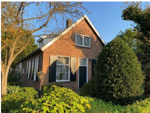
Voordeur op zijgevel, ensemblewaarde met voortuin
