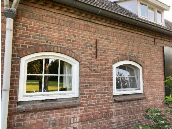
Getoogde zesruit stalramen, muuranker, rollaag plint
