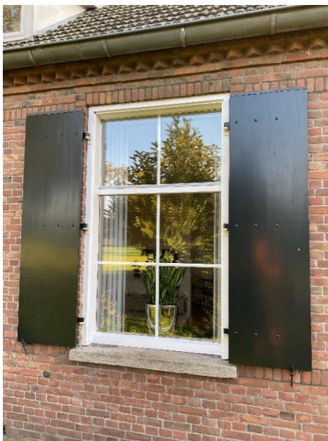
Raamvensters en kozijnen, kruisverband metselwerk, rollaag boven en onder
