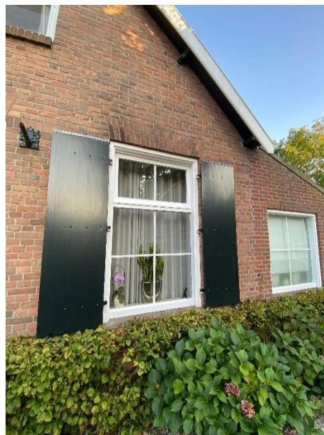
Raamvensters en kozijnen, kruisverband metselwerk, rollaag boven en onder
