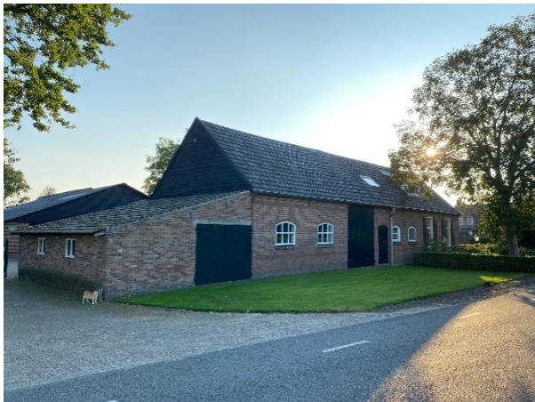
Voorgevel met stalramen, en rechte hoge staldeuren
