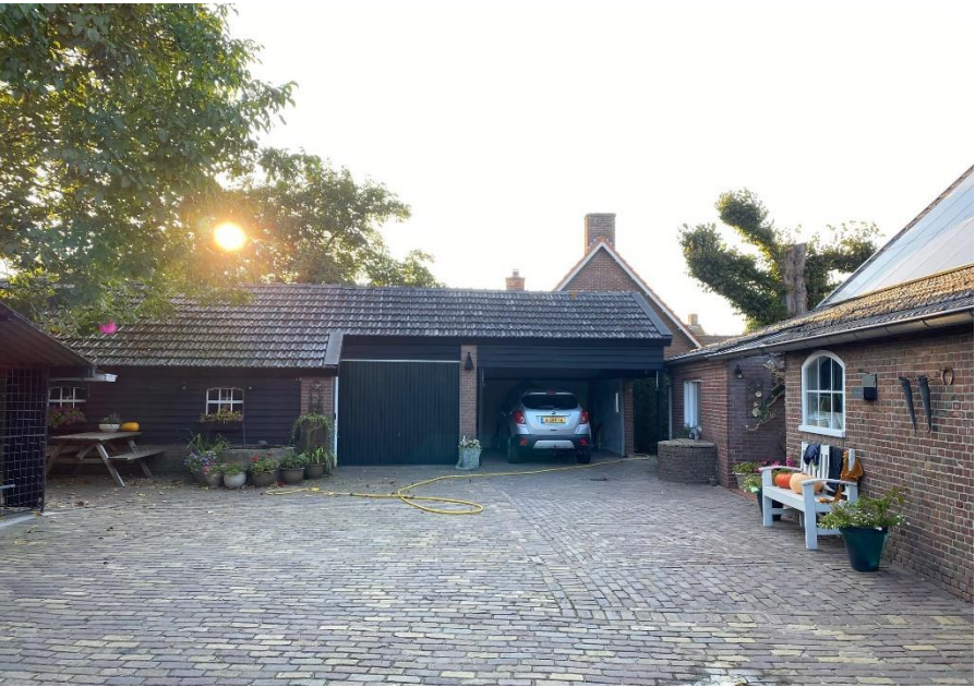
bijgebouw met eveneens zwarte muldenpannen en werf met gebakken klinker (ensemblewaarde)
