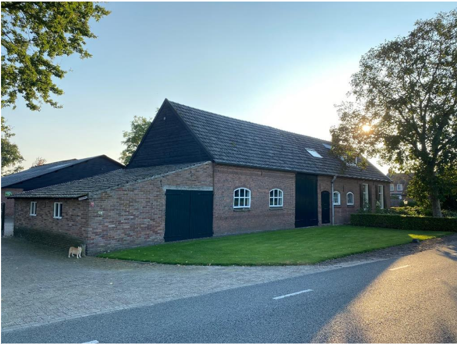
Duidelijk indeling voorgevel, getoogde zesruits stalramen en rechte hoge staldeuren
