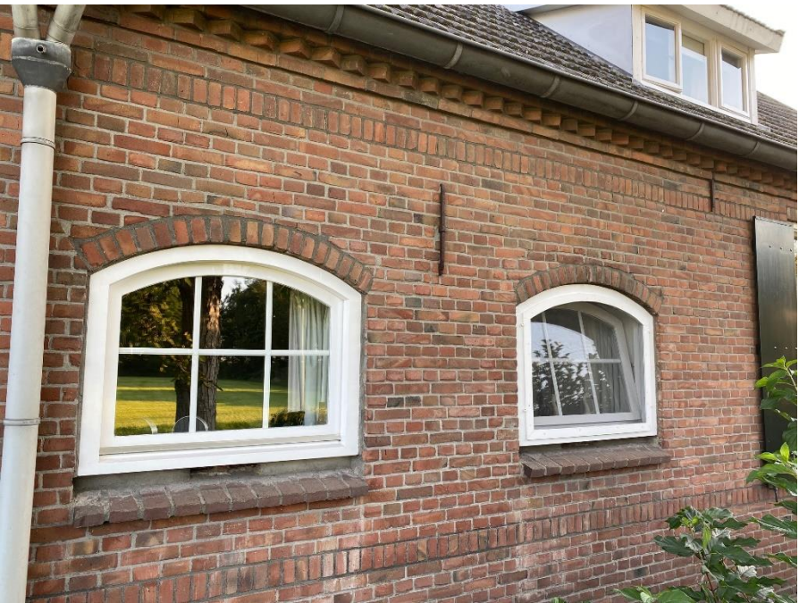
Getoogde zesruit stalramen, muuranker, rollaag plint
