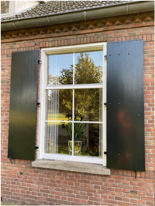
Duidelijk indeling voorgevel, getoogde zesruits stalramen en rechte hoge staldeuren
