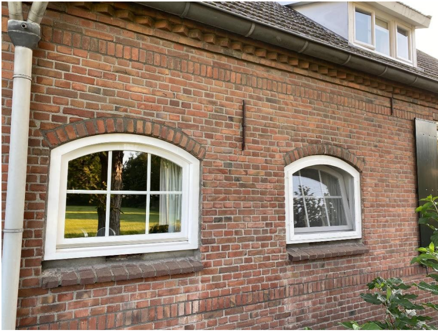
Getoogde zesruit stalramen, muuranker, rollaag plint
