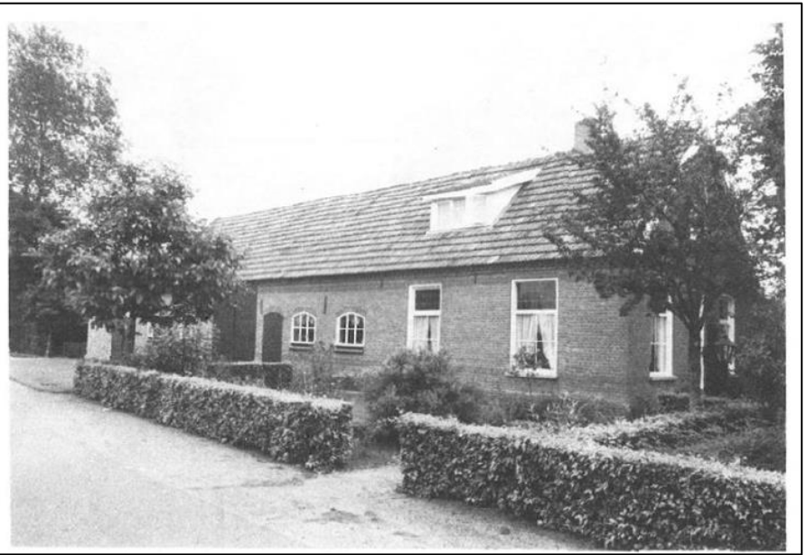
kruisverband metselwerk, muurankers en muizentand onder zinken dakgoot
