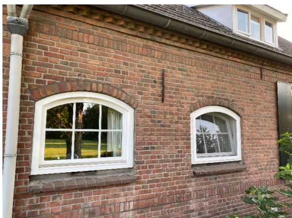
Getoogde zesruit stalramen, muuranker, rollaag plint
