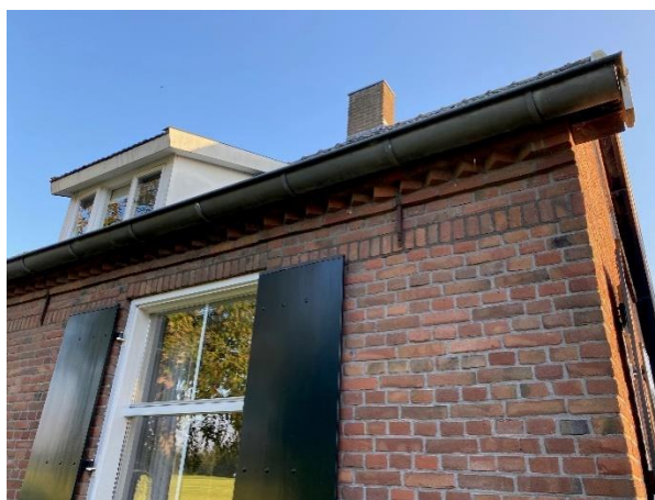
kruisverband metselwerk, muurankers en muizentand onder zinken dakgoot
