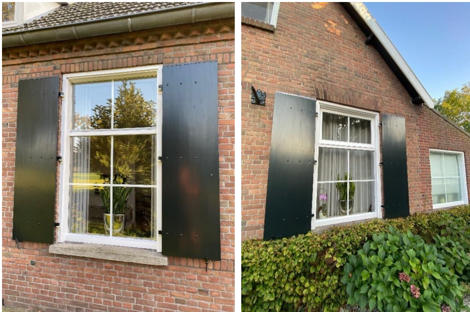
Raamvensters en kozijnen, kruisverband metselwerk, rollaag boven en onder
