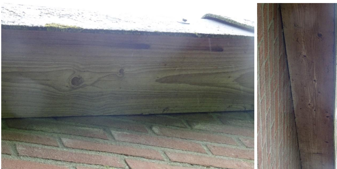
Afbeelding 20 en 21. Overstek afgesloten d.m.v. houten latten. Verder bevat de stal geen spleten en scheuren groter dan 15 mm. Ook zijn veel naden en kieren afgedicht met purschuim. Bron: R.J.L. Bijvelds 17-05-2021
