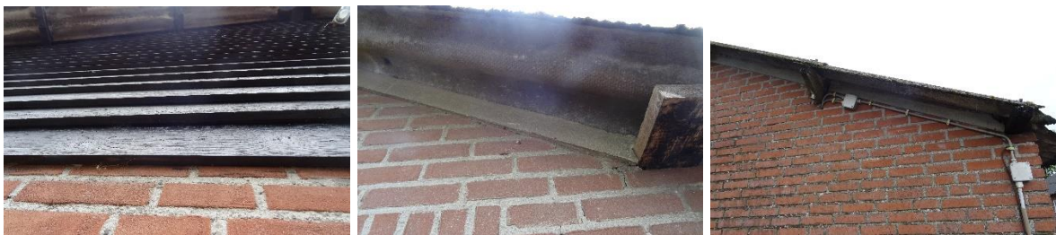
Afbeelding 17, 18 en 19. Gevelbekleding sluit goed aan en de dakplaten bij de kopgevels zijn aangesmeerd met cement. Bron: R.J.L. Bijvelds 17-05-2021
