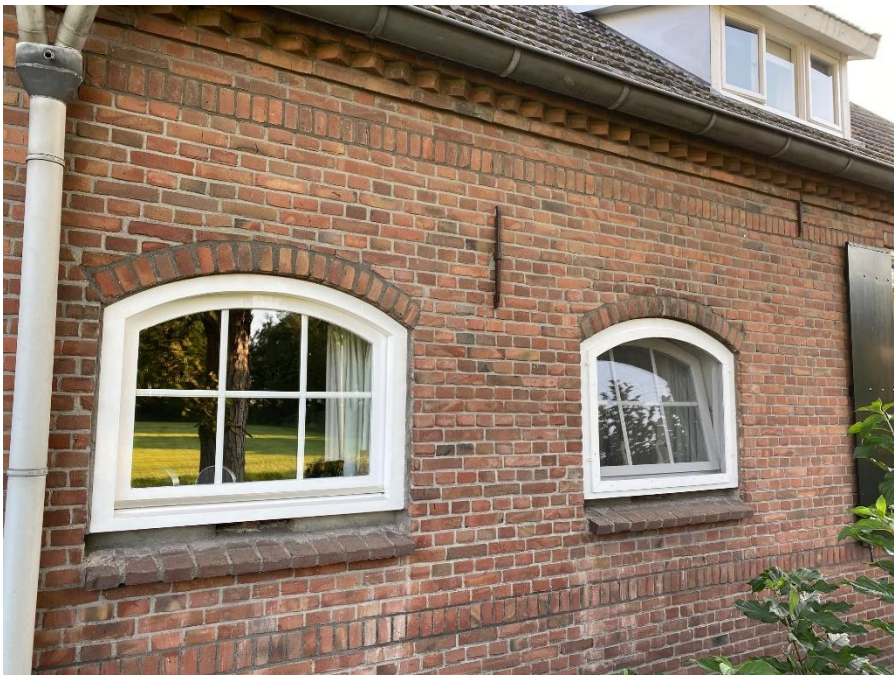
Getoogde zesruit stalramen, muuranker, rollaag plint
