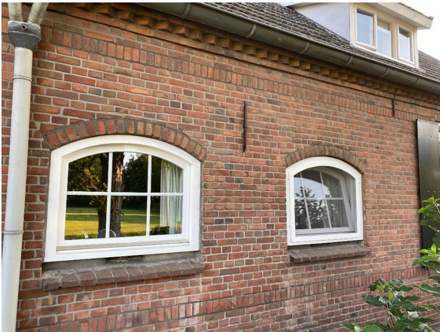
Getoogde zesruit stalramen, muuranker, rollaag plint
