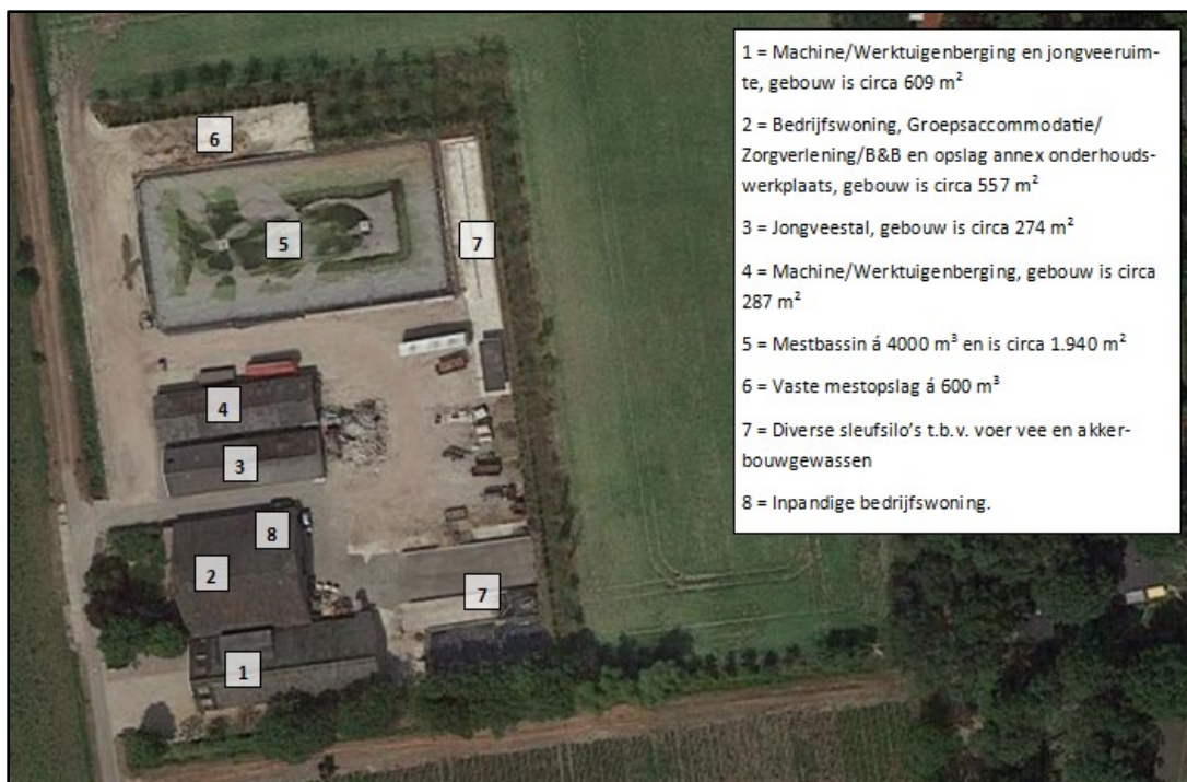
Afbeelding 3: Bestaande gebouwen en bouwwerken aan de Nijssenstraat 4 te Haghorst
