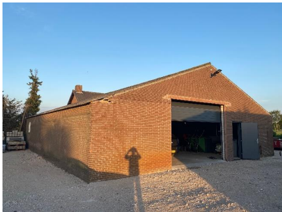
Werkplaats, blijft behouden
