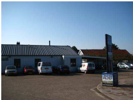
Garagebedrijfspan en bedrijfswoning.
