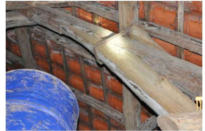
Let op de metalen strip die een verbinding maakt met de gording en de samenkomst van spantbeen en kreupele stijl.
