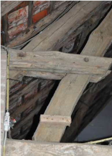
Let op de ijzeren moeren die de blokkeel verbinden met het spantbeen en de kreupele stijl.
