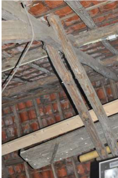
De trekbalke van een verbeterd Hollands spant wordt standaard met twee dunnere balken uitgevoerd.
