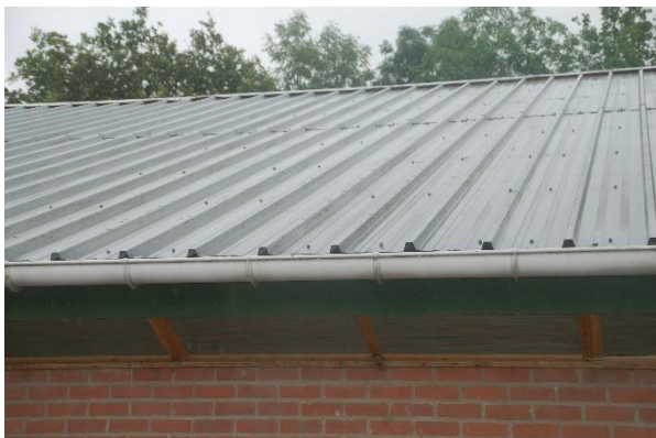
Afbeelding : damwand dak
