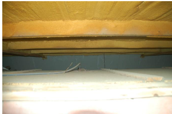
Afbeelding: luchtinlaat onder golfplaten door.
