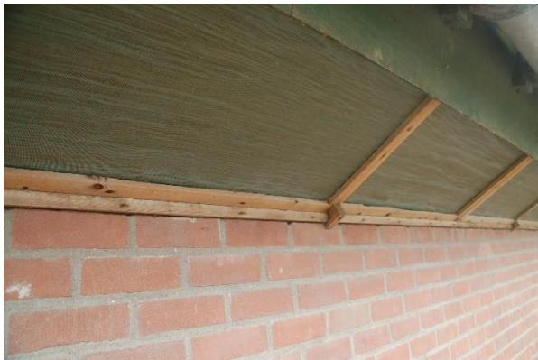
Afbeelding: afgesloten luchtinlaat
