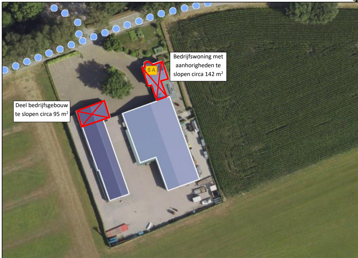
Figuur 9: Te slopen bebouwing
