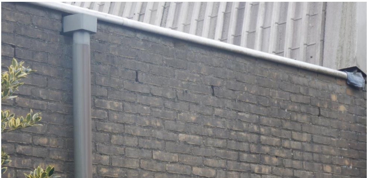
Afb. 6.4.1. Open stootvoegen in de muren geven toegang tot de spouwmuur.
