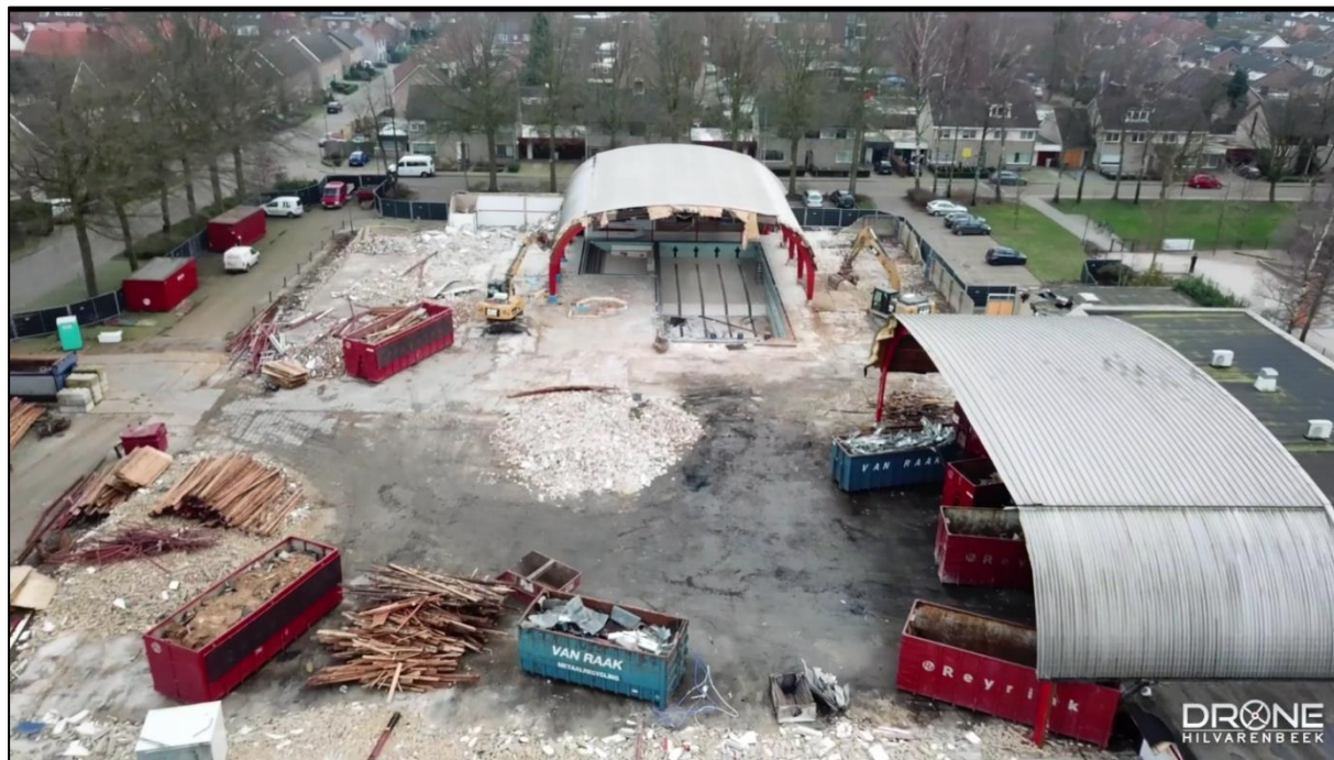
Figuur 3: Overzicht van de sloopwerkzaamheden van de Hispohal (bron: aangeleverd via de opdrachtgever).
