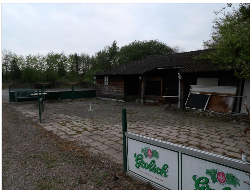
Foto 12: Te slopen schuur
