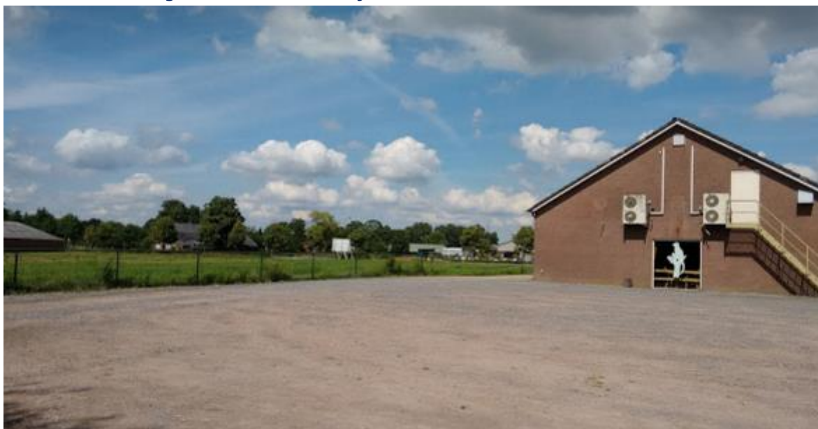
Bestaand horeca gebouw aan achterzijde noordoostwaarts:
