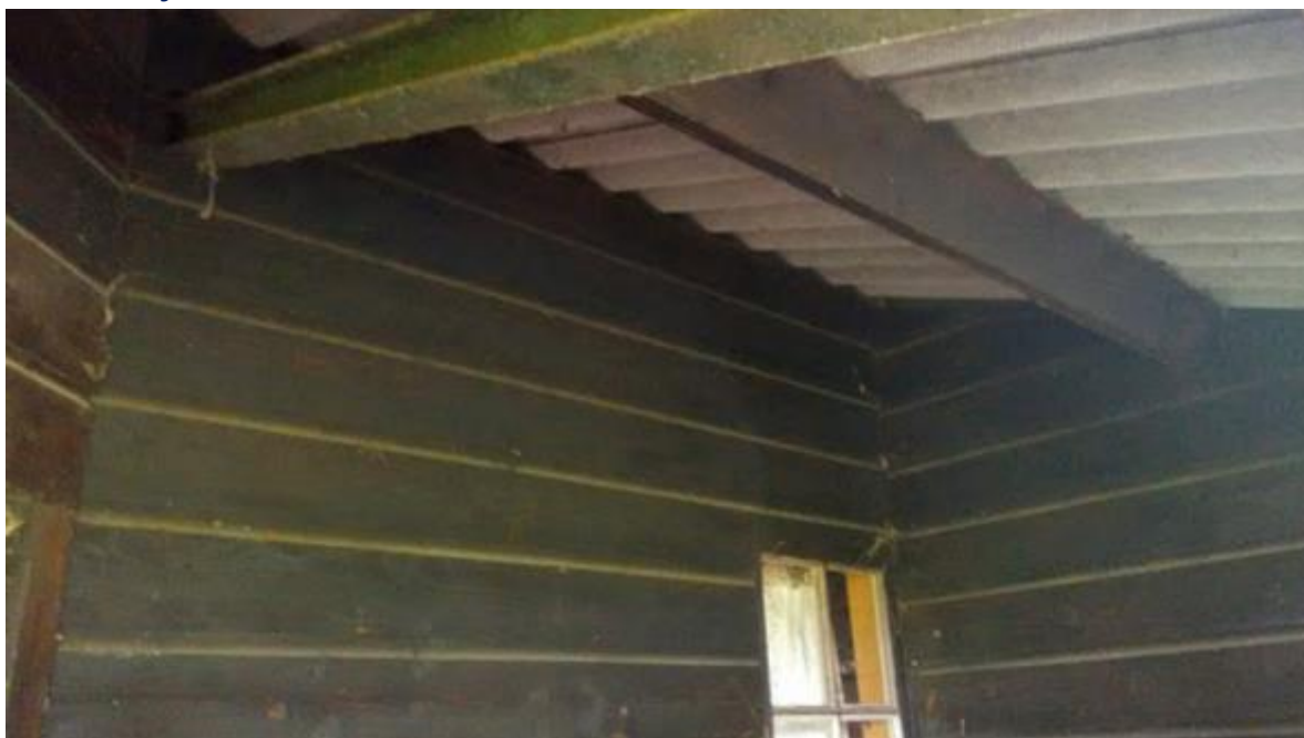
Aan westzijde onder het dak:
