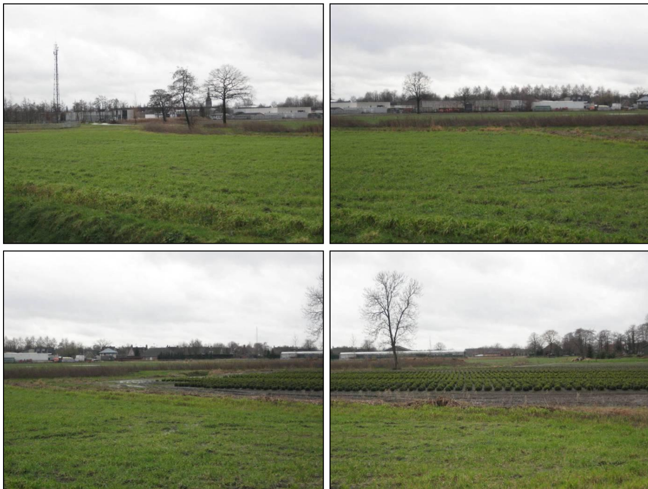
Aanzichten achterkant bebouwing Slibbroek, gezien vanuit het buitengebied
