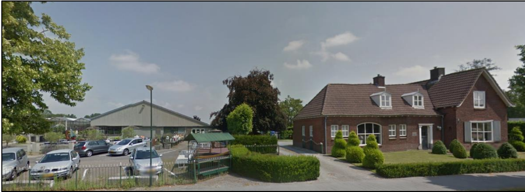
Foto genomen vanaf de Tilburgseweg in de richting van het plangebied. Te zien zijn het voormalig tuincentrum en de bedrijfswoning. Bron: maps.google.nl, 2017.
