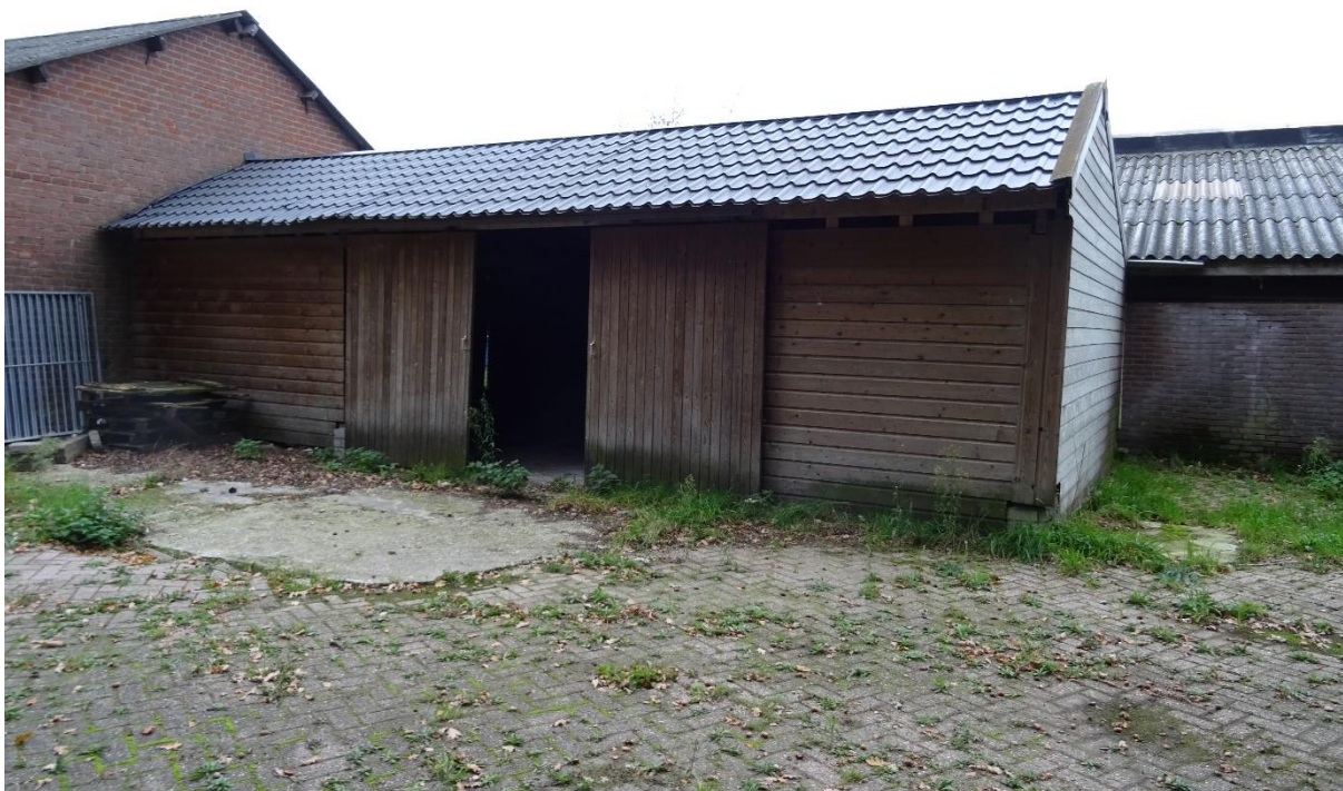
Afbeelding 5: Bestaand te slopen bijgebouw op het kavel. Bron: R.J.L. Bijvelds 20-10-2020
