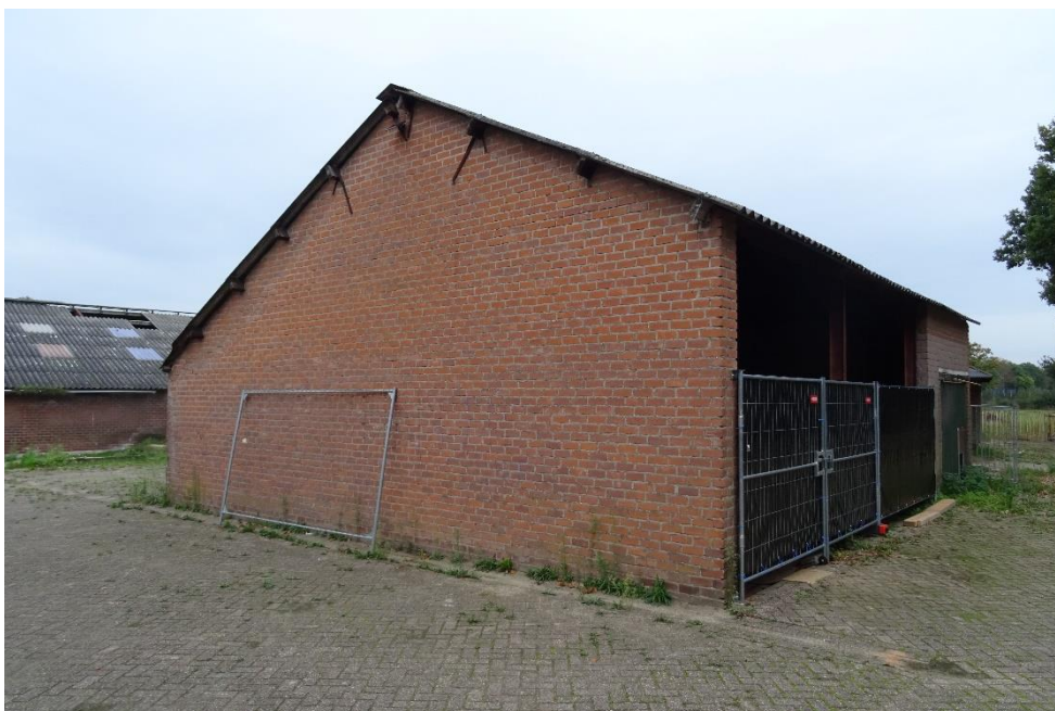
Afbeelding 6: De veldschuur waarvan het dak vervangen wordt. Bron: R.J.L. Bijvelds 20-10-2020
