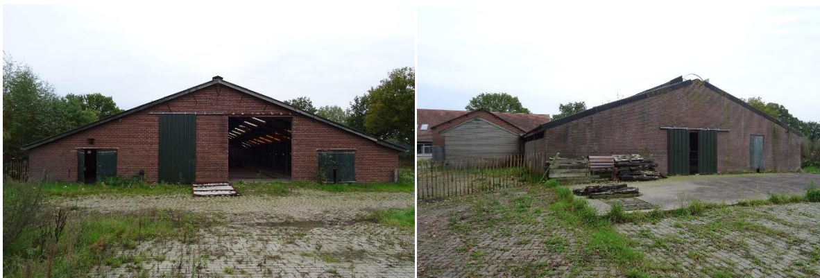
Afbeelding 3 en 4: Bestaande te slopen melk- en jongveestal op het kavel. Bron: R.J.L. Bijvelds 20-10-2020
