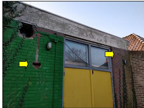
Figuur 10. Gaten bieden toegang tot de spouwmuur. Dit vormen potentiële vaste rust- en verblijfplaatsen gebouwbewonende vleermuizen.
