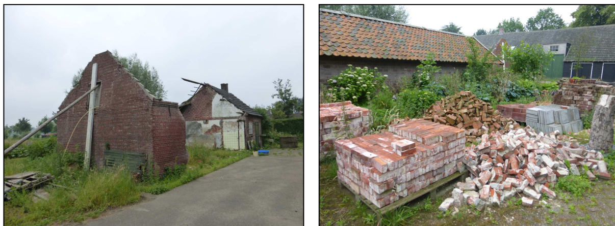
Figuur 7: In renovatie zijnd bakhuis
