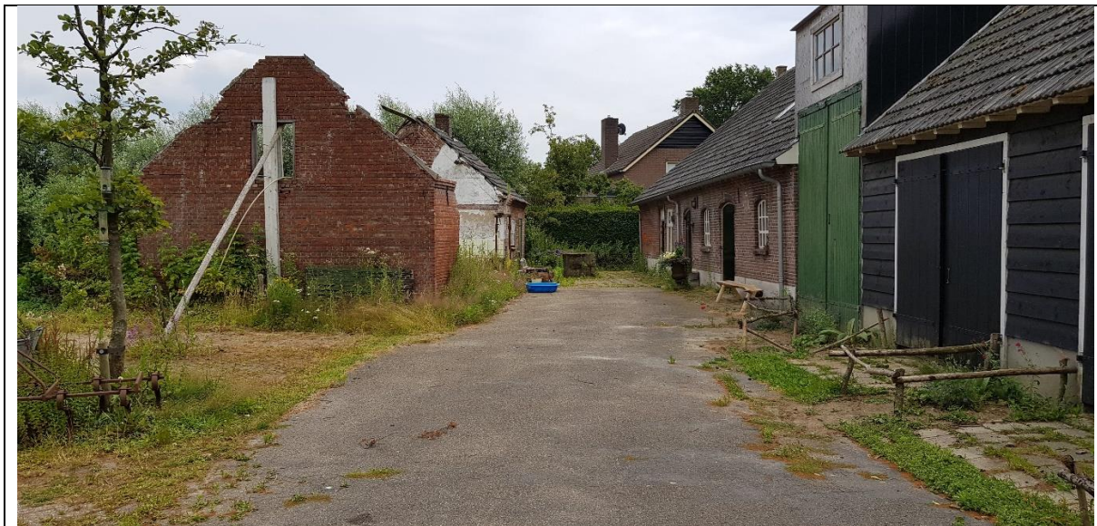
erf, asfaltverhard, met bakhuis (l) en woonboerderij (r).
