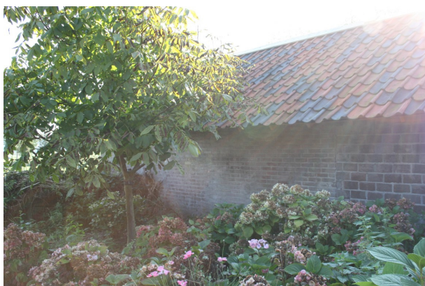
Linkerzijgevel met overgang metselwerk
