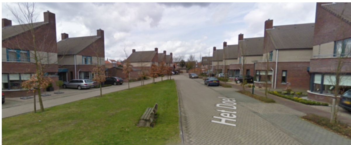
Foto's bestaande situatie en omgeving aan Het Doel. Bron: Google.com.
