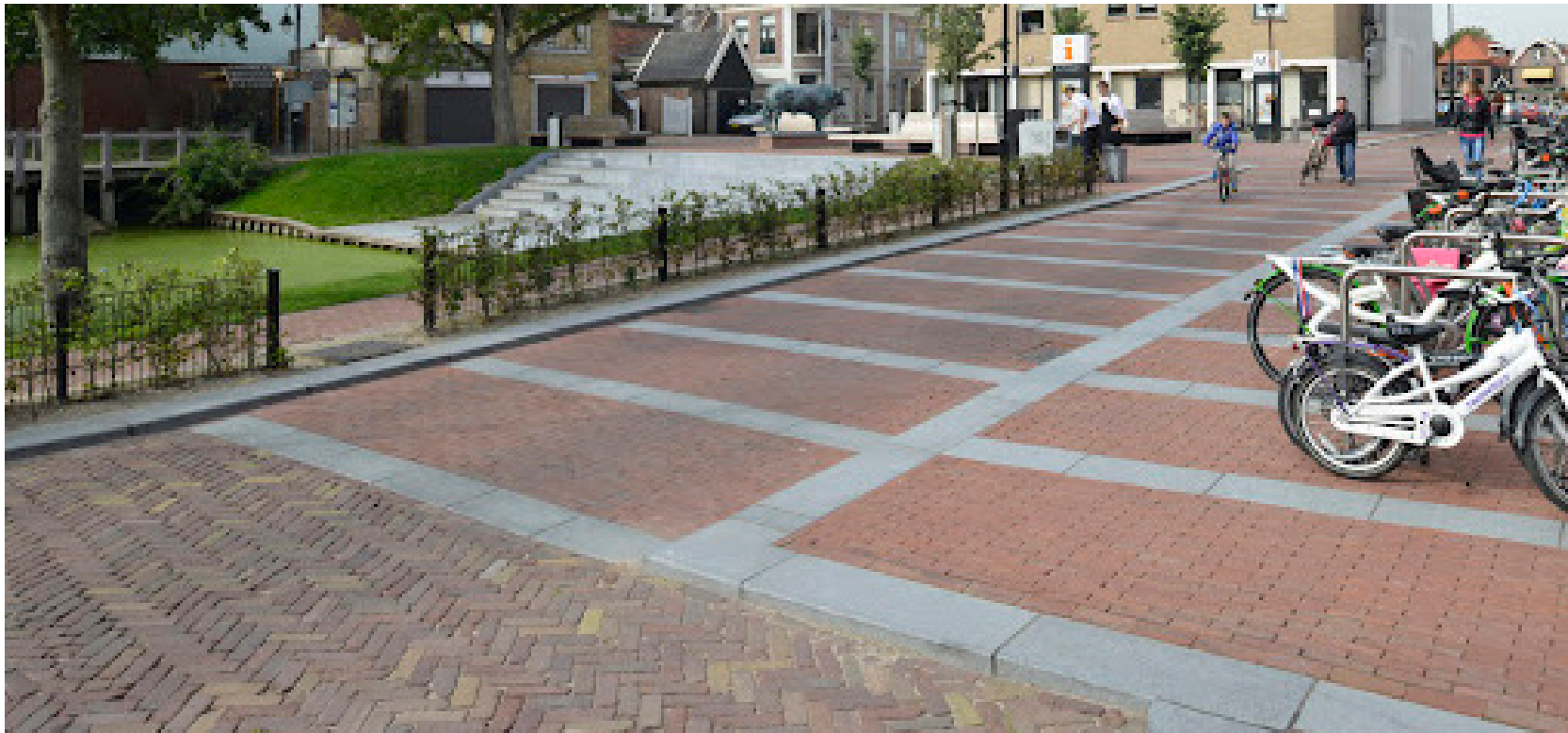
Shared Space voor fietsers en gemotoriseerd verkeer. Verblijfsruimte in zelfde materiaal maar geleiding aangebracht met klein niveauverschil. Stroken in afwijkend materiaal voor snelheidsremmend effect.
