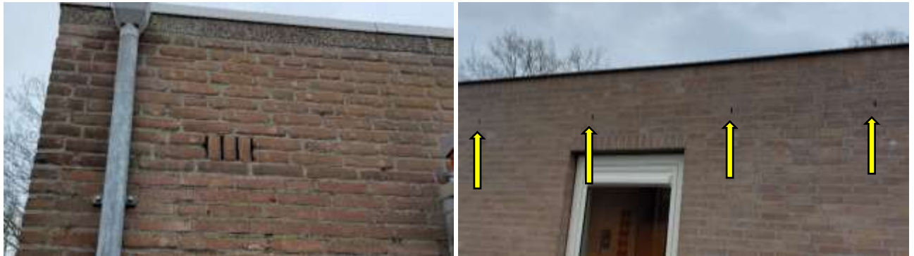
Figuur 4.4.15. De basisschool bevat een ventilatiesleuf en enkele open stootvoegen waardoor vleermuizen de spouw kunnen bereiken.
