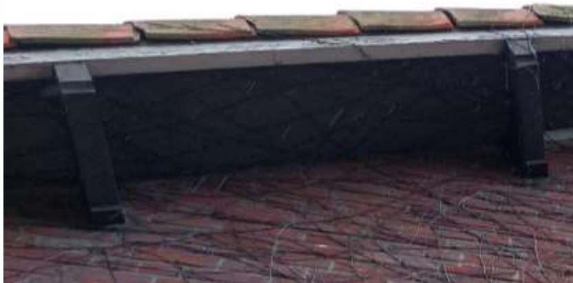
Figuur 4.4.12. Voor gierzwaluwen is de opening tussen het boeiboord en de gevelpannen te nauw. Vleermuizen kunnen er wel onderdoor kruipen.
