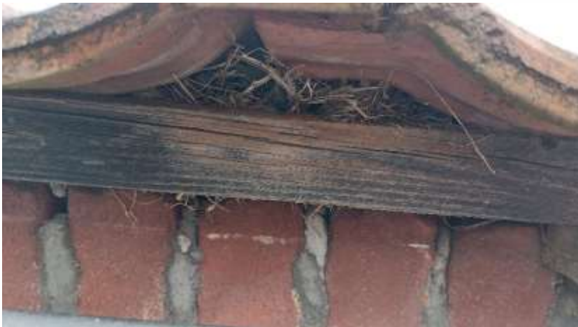
Figuur 4.4.10. Door de afwezigheid van vogelschroot kunnen huismussen onder de dakpannen nestelen.
