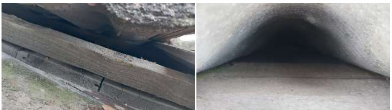
Figuur 4.4.6. Onder het pannendak en het golfplaten dak is geen vogelschroot aanwezig. Huismussen kunnen er daardoor onder nestelen.
