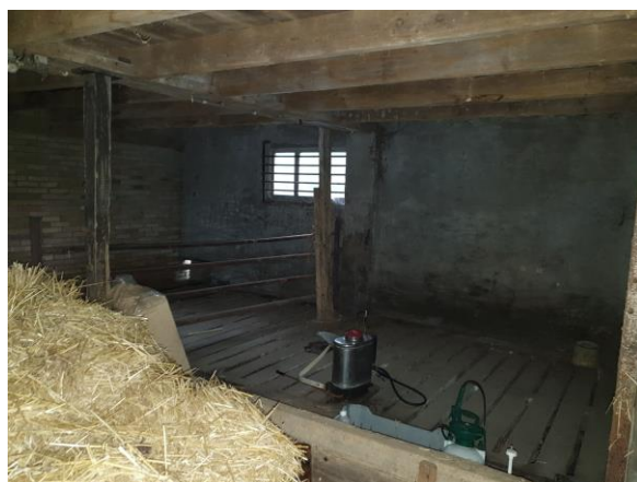
In het achterste gedeelte van de loods onder de zolders zijn geen sporen van marterachtigen. Katten aangetroffen in deze ruimte. De katten kunnen zich overal in en rondom de loods, de kippenhokken en de kapschuur bewegen.
