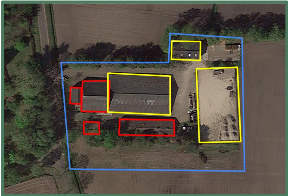
Globaal omlijnde planlocatie in blauw met de te slopen gebouwen in rood en de te behouden gebouwen in geel. Bron: Google Earth.
