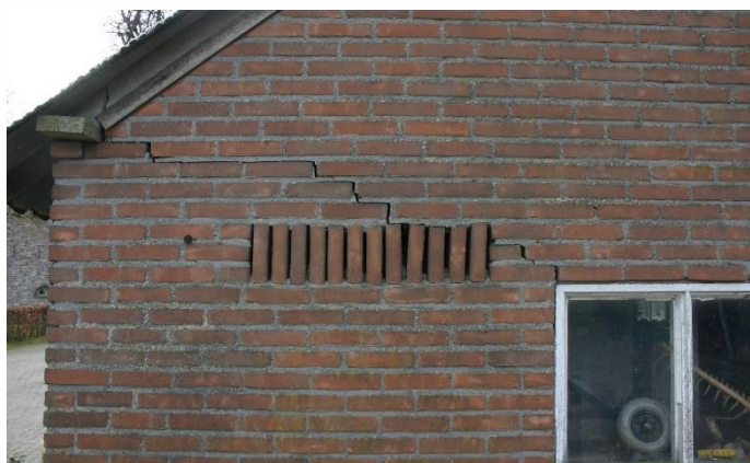
Figuur 4.4.2. De ventilatiegleuven en kieren kunnen toegang tot de spouw verlenen aan vleermuizen.
