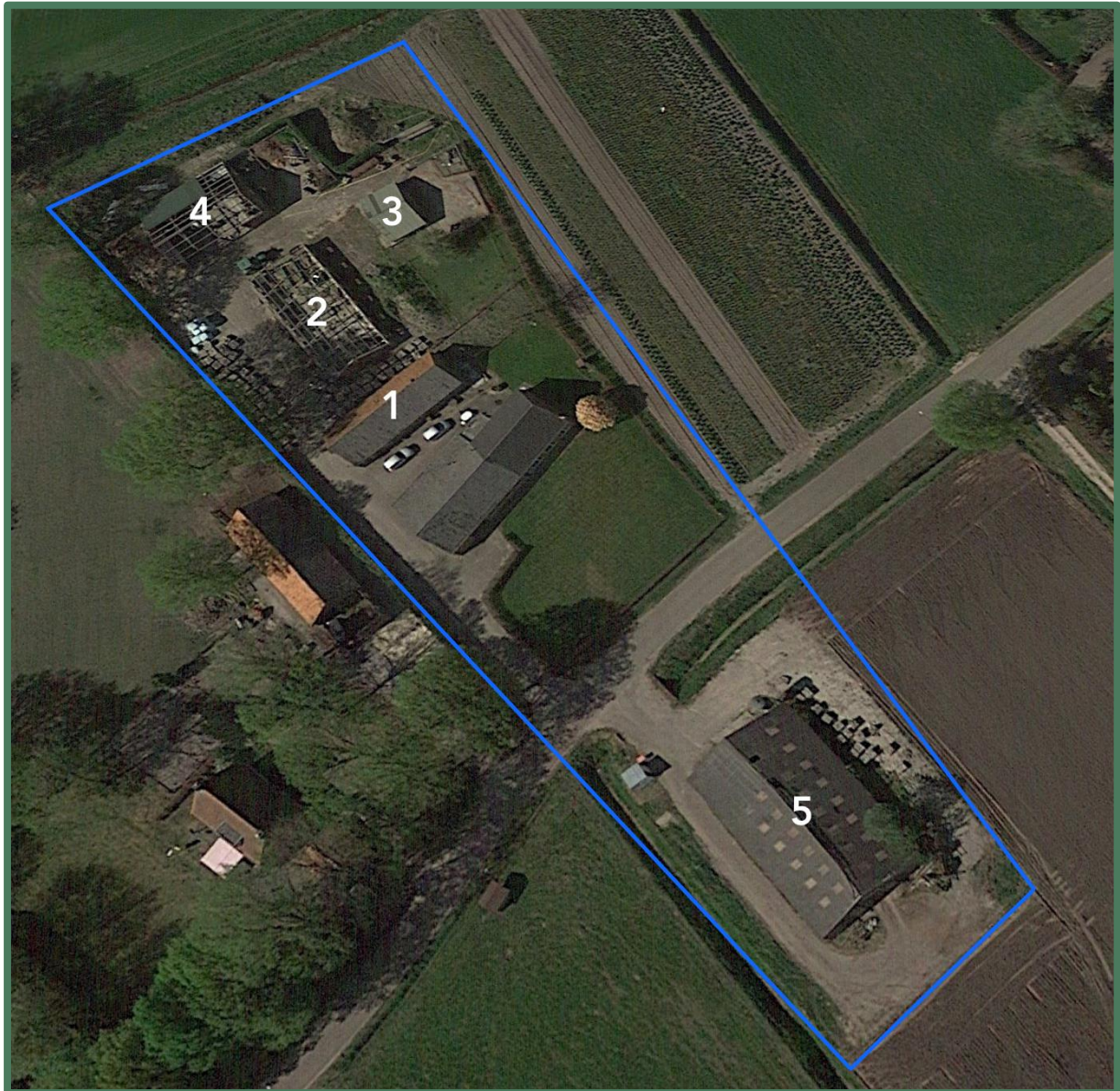
De te slopen overtollige bebouwing met nummers aangegeven. Globaal omliggende planlocatie in blauw. Bron: Google Earth
