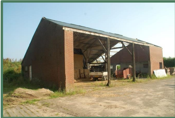
Gebouw 4 met links de talud
