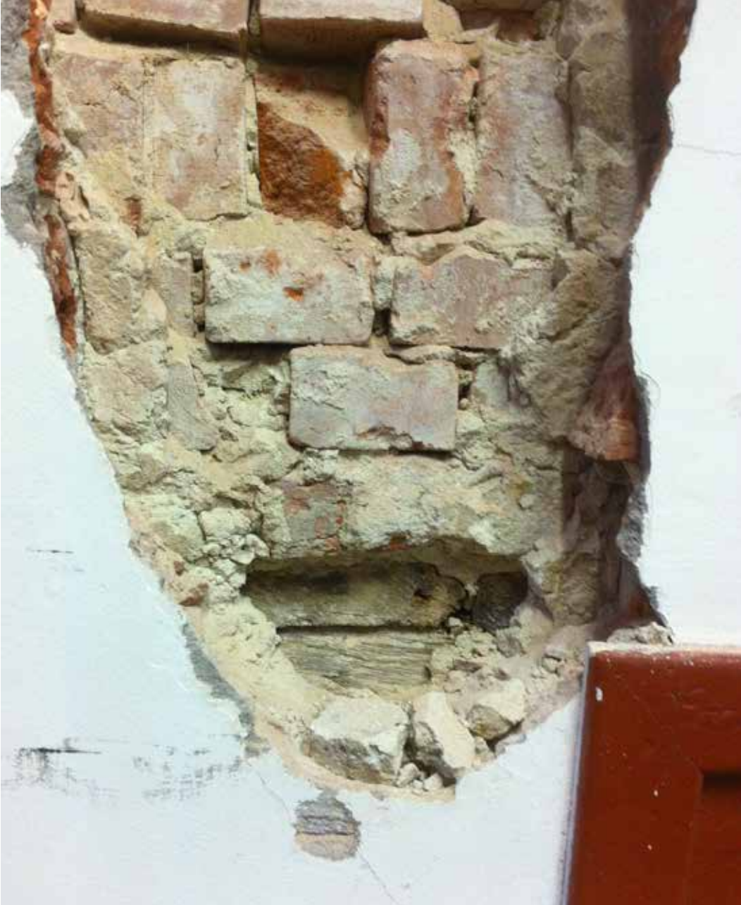
detail opbouw oven, onder de hergebruikt balkjes en planken, daarboven de machinaal vervaardigde stenen
