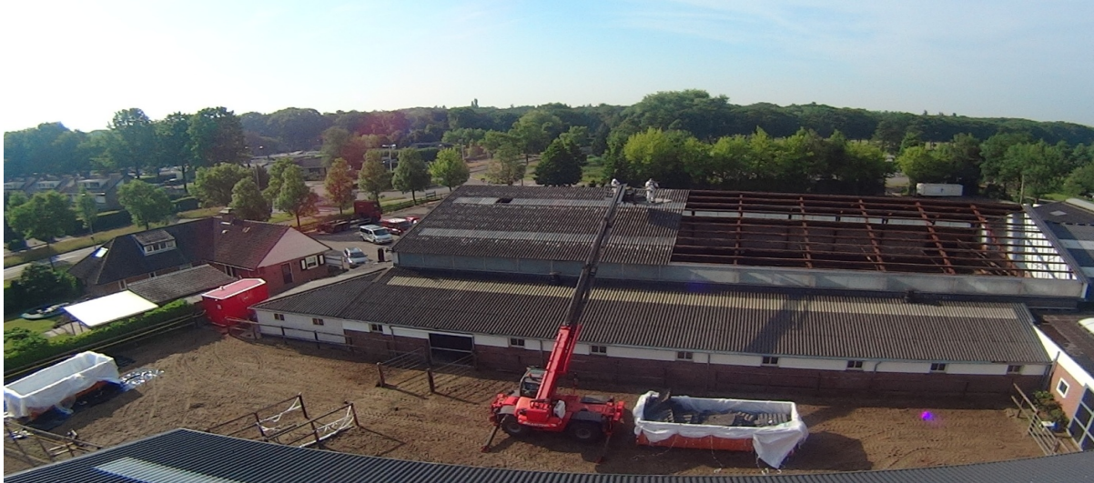
Voorbeeld van de ruimte die nodig is om met verrijker op het dak te kunnen werken
