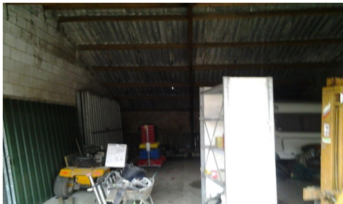
Voorbeeld van hoe het NIET moet. Wij kunnen niet starten met saneren als de ruimte niet is leeggemaakt!
