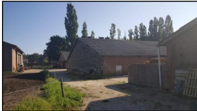
Figuur 5. Overzicht onderzoekslocatie vanaf het noordwesten.
