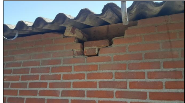
Figuur 10. Openingen in de muren geven toegang voor vleermuizen maar ook andere diersoorten om het gebouw te betreden.
