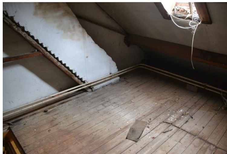
Zoldervloer uit de bouwtijd met smalle grenen planken.
