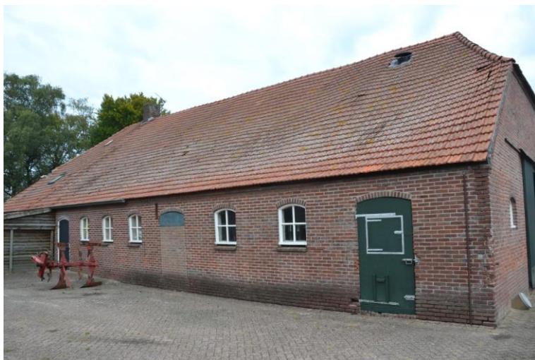
Rechterzijgevel t.h.v. het gehele vm. bedrijfsgedeelte.
