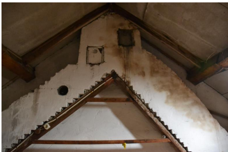
Zolder met rookkanalen boven het woongedeelte.
