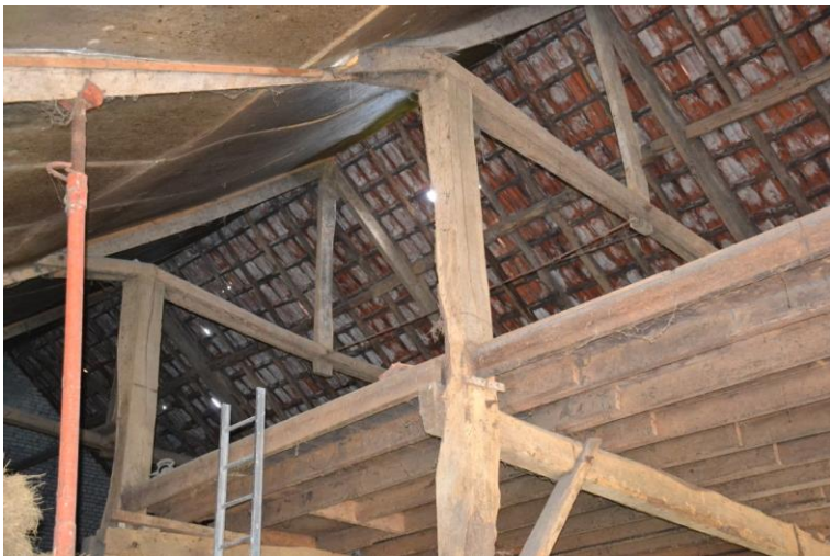
Zicht op de gehele hoofddraagconstructie.
