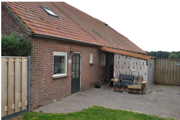
Rechterzijgevel t.h.v. het woonhuisgedeelte.
