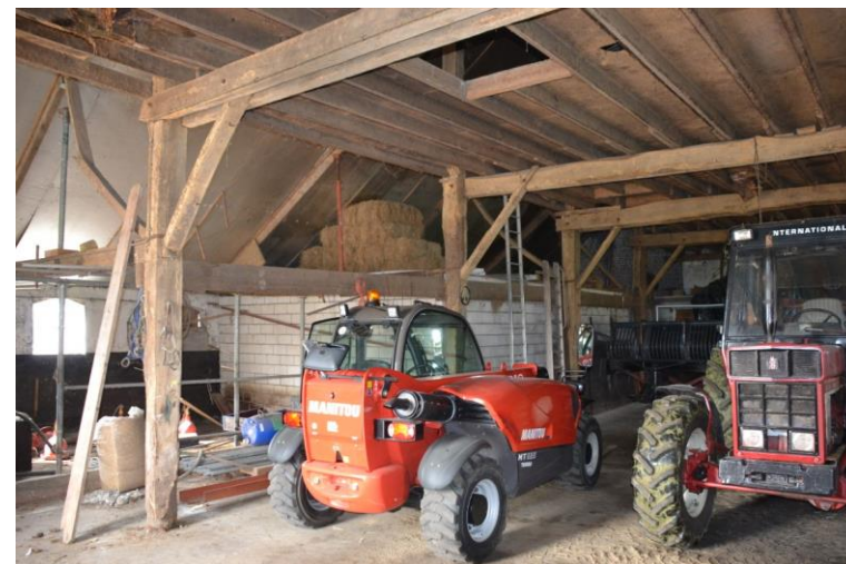
Het interieur van het schuurdeel vanaf de achtergevel naar de rechterzijgevel gezien.
