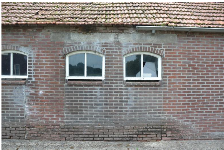
Rechterdeel van linkerzijgevel met de dichtgezette opening die zich onder de betonnen latei bevond.
