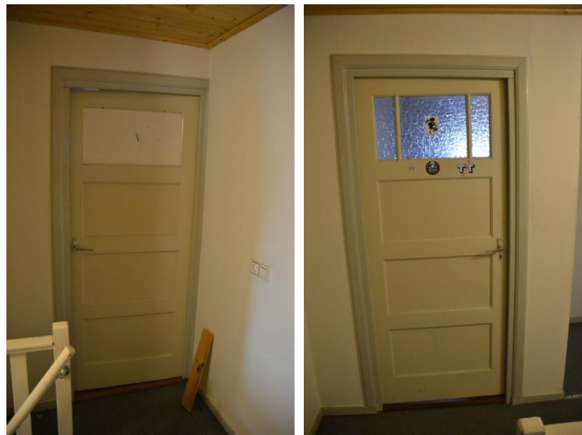
Paneeldeuren uit de bouwtijd tussen overloop en slaapkamers.
