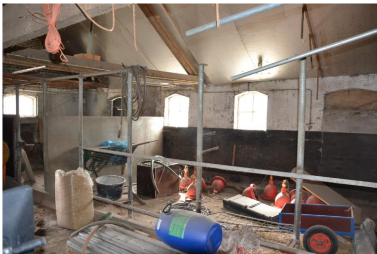
Stalruimte in het schuurdeel met kenmerkende tweekleurige wandafwerking.
