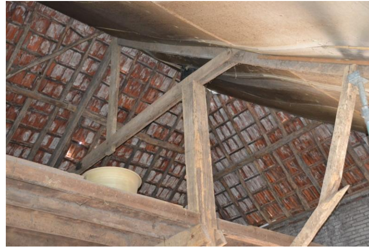
Eén van de steekspanten met makelaar tussen de trekbalen.
