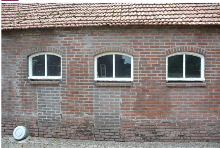
Linkerzijgevel bedrijfsdeel met dichtgezette varkensdeuren.
