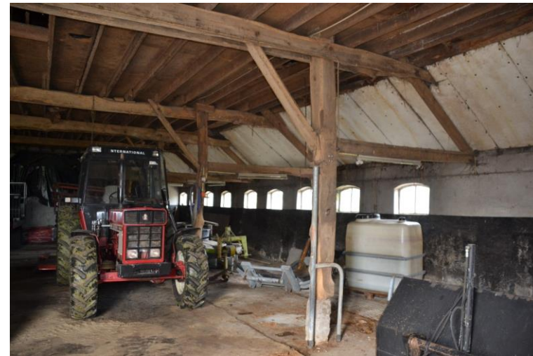
Het interieur van het schuurdeel vanaf de achtergevel naar de linkerzijgevel gezien.
