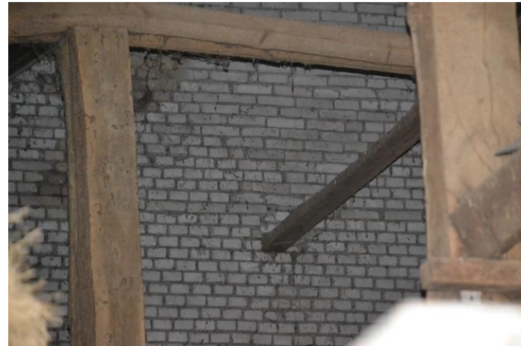
Detailopname van de brandmuur met twee metselverbanden zichtbaar.
