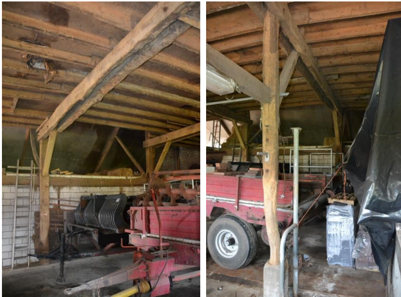
Links en rechts: beeld van de draagconstructie met dubbele dwarsbalken.
