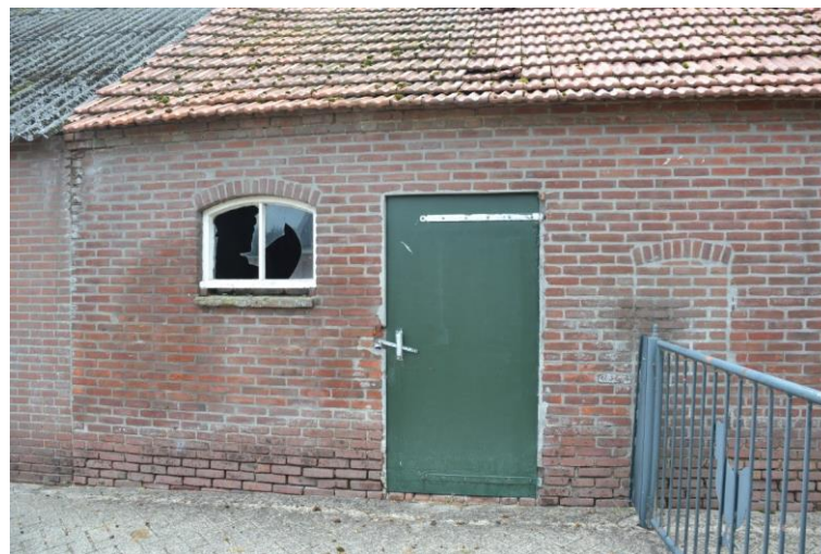
Linkerzijde van het oorspronkelijk bedrijfsdeel met recht een dichtgemetselde varkensdeuropening.
