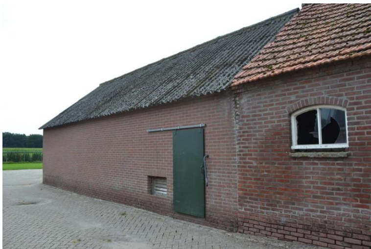
Het later aangebouwde deel van de linkerzijgevel met overgang naar de oorspronkelijke zijgevel.
