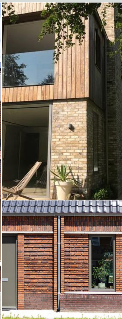
Zorgvuldige detaillering in metselwerk en aansluiting regenwaterafvoer.
