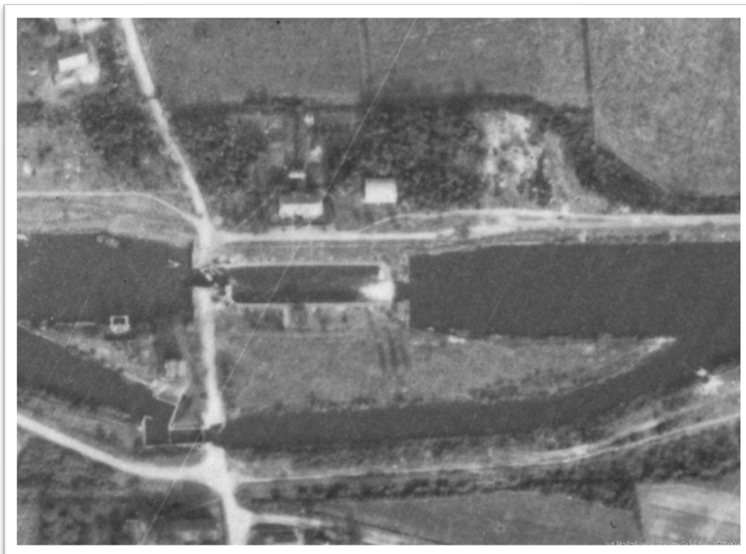
Figuur 5: 1944: Oorlogsschade aan de ophaalbrug en de sluis bij Haghorst, gezien vanuit de lucht. Bron: National Collection of Aerial Photography (NCAP) te Edinburgh.
